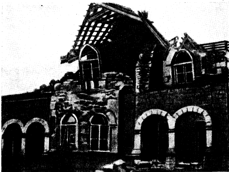
Рис. 222. Разрушения из-за плохого материала. Балаклава, Крым, 1927 год.
